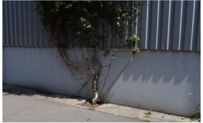
Abb. 61 Beispiel aus Stuttgart: Die gitterförmige Kletterhilfe der bodengebundenen Fassadenbegrünung ermöglicht eine flächige Begrünung in der Vertikalen. (BuGG)
