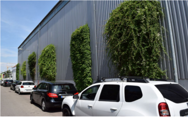
Abb. 60 Beispiel aus Stuttgart: an einer mit Trapezblech verkleideten Hallenwand wurde eine bodengebundene Fassadenbegrünung mit Kletterhilfen installiert. (BuGG)
