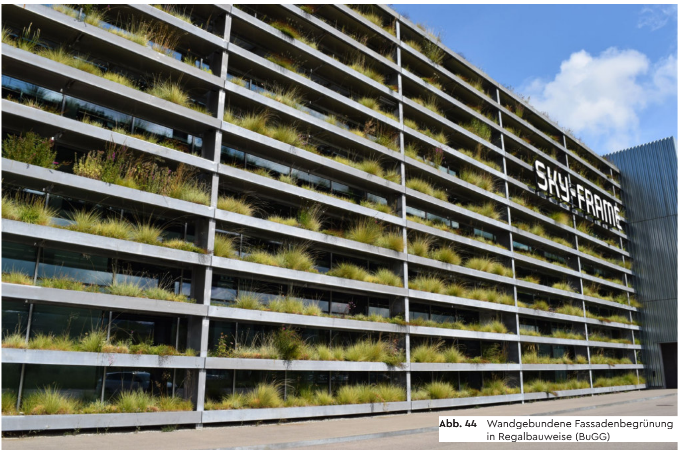
Abb. 42 Wandgebundene Fassadenbegrünung in Regalbauweise (BuGG)
