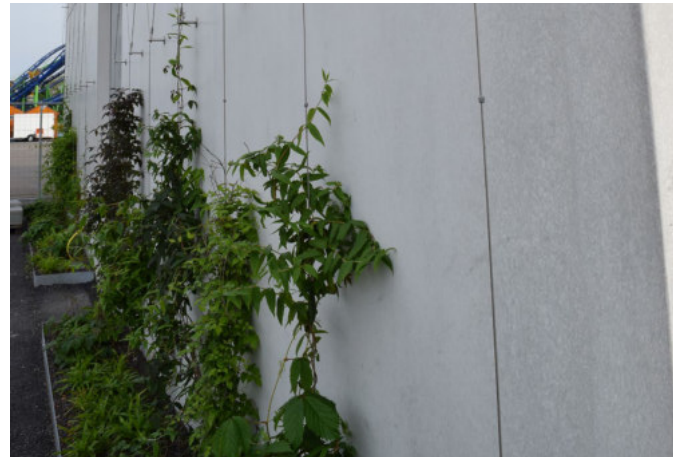
Abb. 47 Fassadenkonstruktion als WDVS-System mit Gerüstkletterpflanzen und Kletterhilfe als Seilsystem (BuGG)
