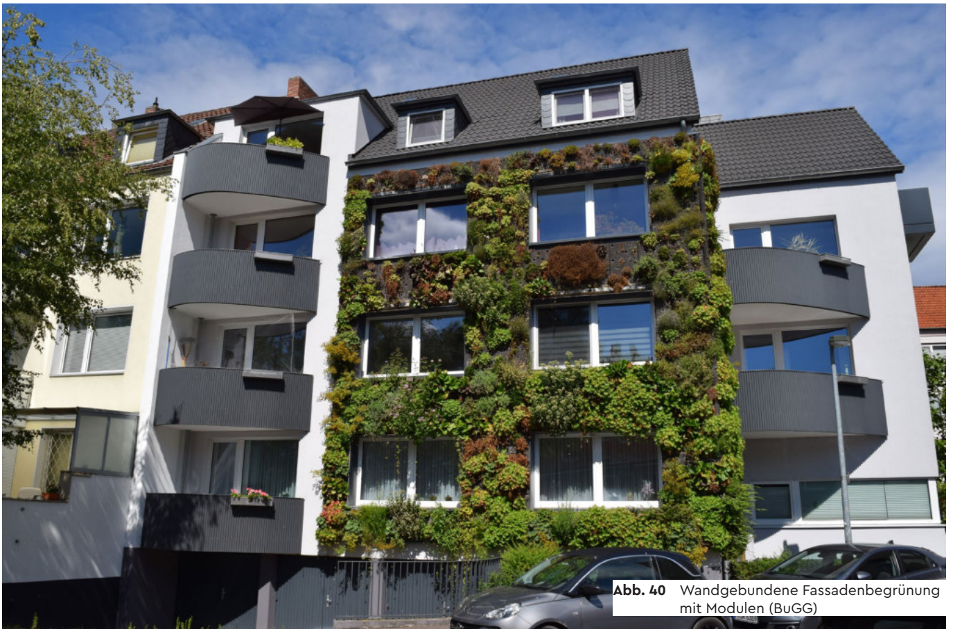
Abb. 38 Wandgebundene Fassadenbegrünung mit Modulen (BuGG)
