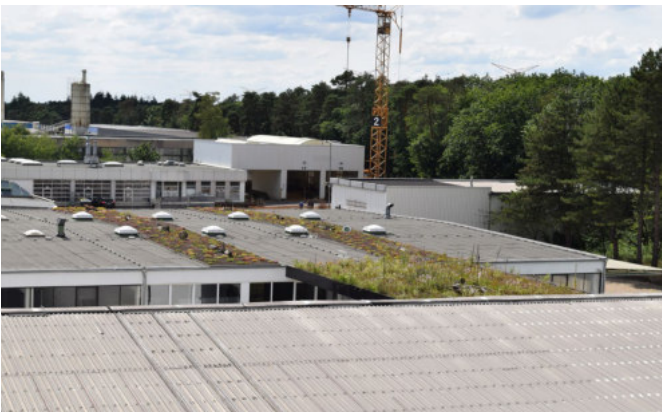
Abb. 62 Nachträgliche extensive Dachbegrünung bei der Fa. Reckhaus in Bielefeld: „Streifenförmige“ Begrünung, vermutlich über einer Stützmauer. (BuGG)
