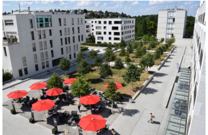
Abb. 10 Hohe Stauden-Rasen-Bäume (Tiefgarage) (BuGG)
