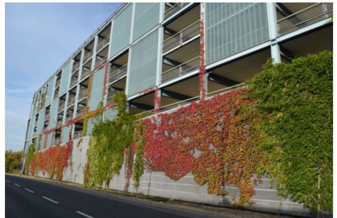
Abb. 48 Fassadenkonstruktion in Stahlbauweise mit Gerüstkletterpflanzen auf Gitterstruktur (BuGG)
