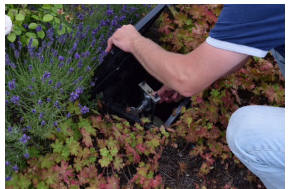
Abb. 27 Blick in den Kontrollschacht (BuGG)
