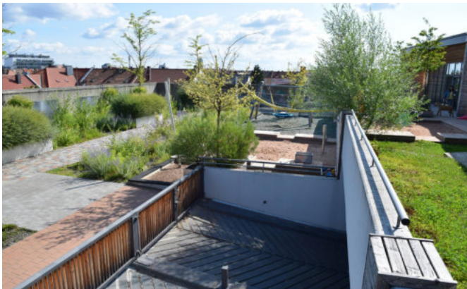
Abb. 72 Musikhaus Klier in Nürnberg: Auf dem obersten Parkdeck des bestehenden Parkhauses wurde nachträglich eine begrünte und begehbare Fläche mit Spieleinrichtungen für eine Kita angelegt. (BuGG)
