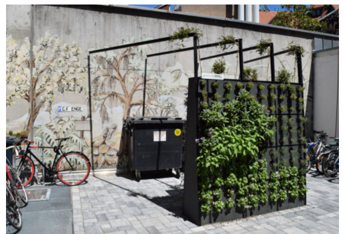
Abb. 32 Freistehende Grünwand (BuGG)
