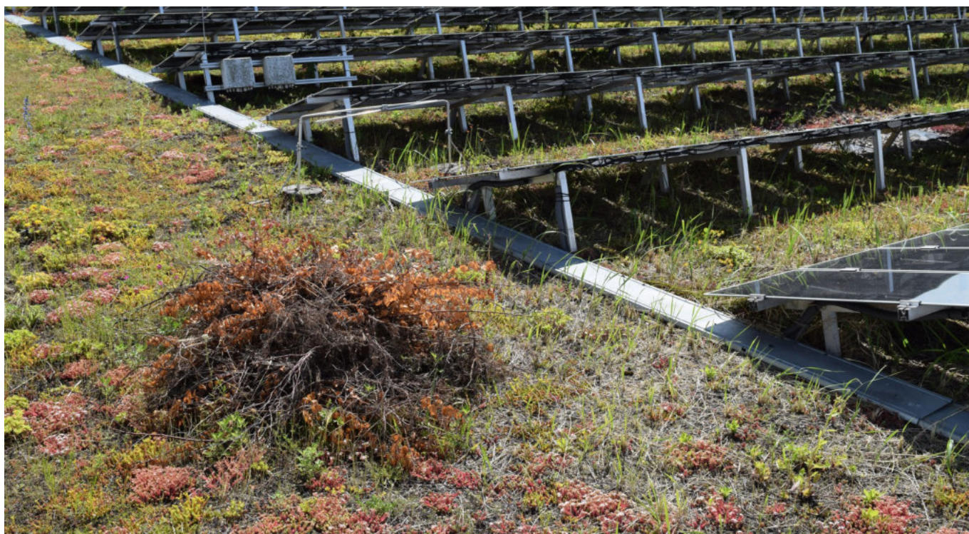
Abb. 30 Pflegemaßnahmen auf einem Solar-Gründach (BuGG)
