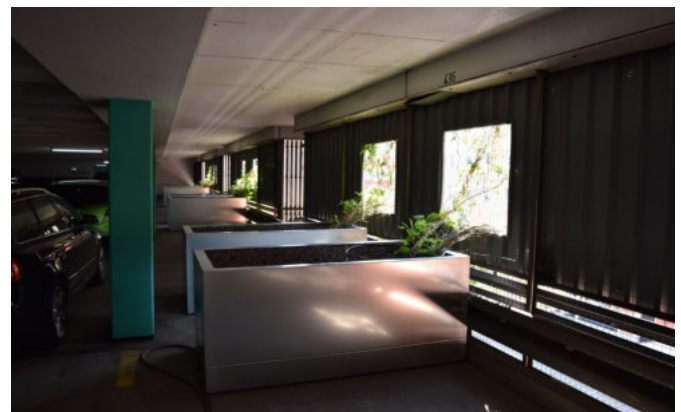
Abb. 69 Musikhaus Klier in Nürnberg: Auf einer Parkdeckebene wurden Pflanzgefäße eingebaut und Öffnungen in der Fassade geschaffen. (BuGG)
