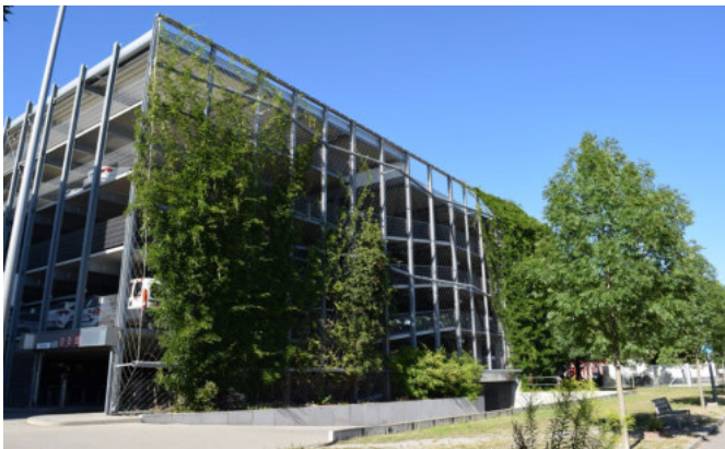
Abb. 66 Parkhaus in Heppenheim: Eine bodengebundene Fassadenbegrünung, die mittels Edelstahlnetz geleitet wird und eine Kletterhilfe findet. (BuGG)
