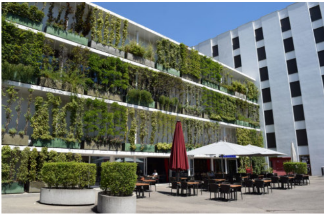
Abb. 41 Wandgebundene Fassadenbegrünung in Regalbauweise (BuGG)
