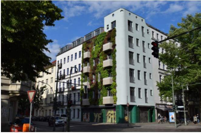
Abb. 37 Wandgebundene Fassadenbegrünung mit Vlies (BuGG)
