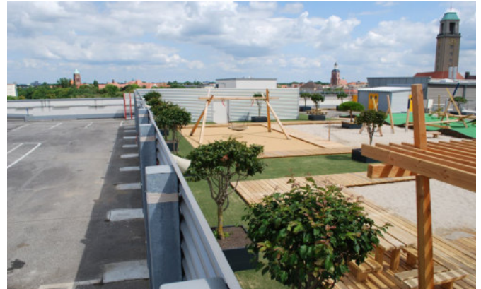
Abb. 71 Beispiel aus Berlin: Da die Statik begrenzt war, musste Kunstrasen verlegt werden und nur an bestimmten Stellen konnten Pflanzgefäße gestellt werden. (BuGG)
