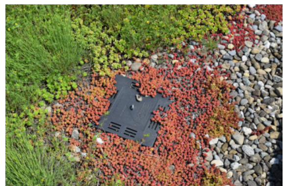
Abb. 29 Überwachener Kontrollschacht (BuGG)
