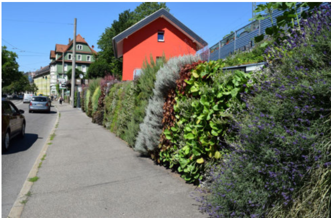
Abb. 38 Wandgebundene Fassadenbegrünung mit Modulen (BuGG)
