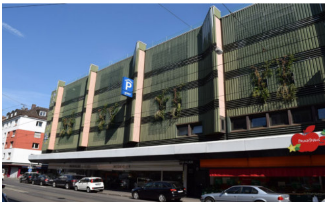
Abb. 68 Musikhaus Klier in Nürnberg: Die Fassade des Parkhauses wurde nachträglich begrünt. Kletterhilfen sind in Form von Gittern angebracht. (BuGG)
