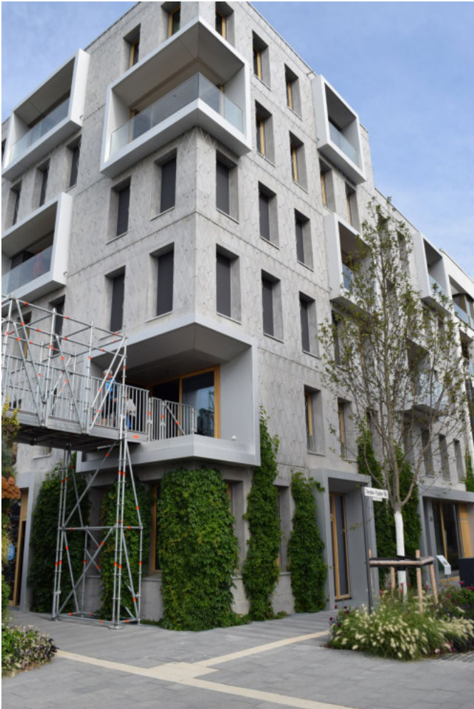
Abb. 46 Fassadenkonstruktion in massiver Bauweise mit Gerüstkletterpflanzen und Kletterhilfe in Gitterform (BuGG)
