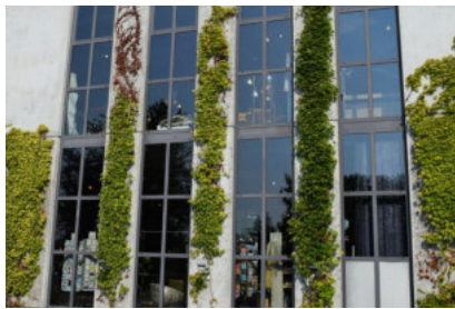
Abb. 50 Bodengebundene Fassadenbegrünung mit Selbstklimmer (BuGG)
